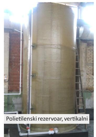
Polietilenski rezervoar, vertikalni
